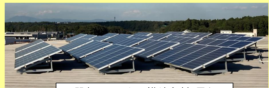
関東エリアセンター（物流倉庫）屋上
